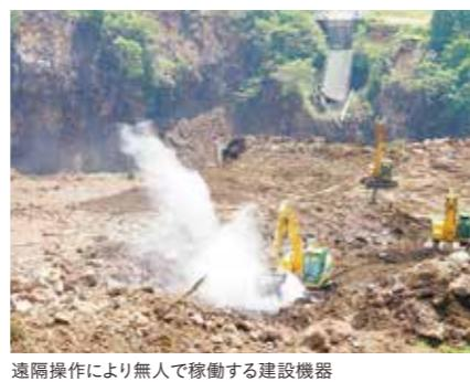
遠隔操作により無人で稼働する建設機器
