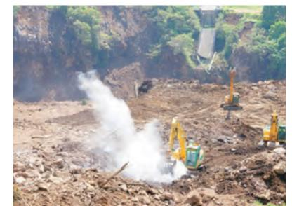
遠隔操作により無人で稼働する建設機器
